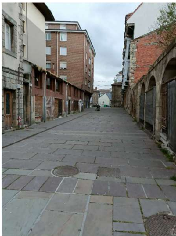
Línea de montaje (C/San Sebastián)
