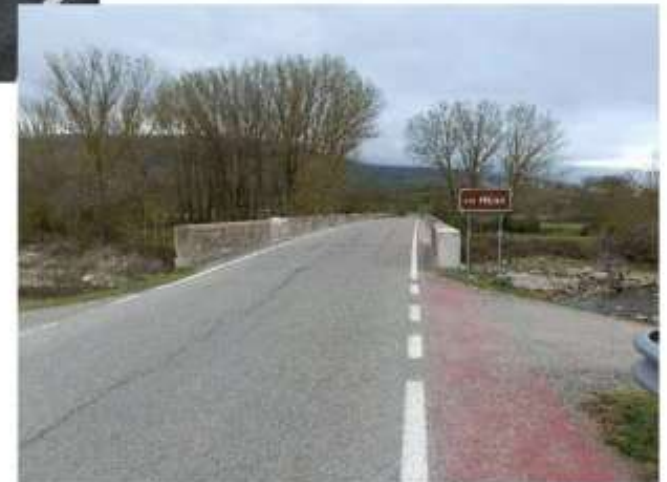
Puente Río Hija. Precaución, doble sentido.
